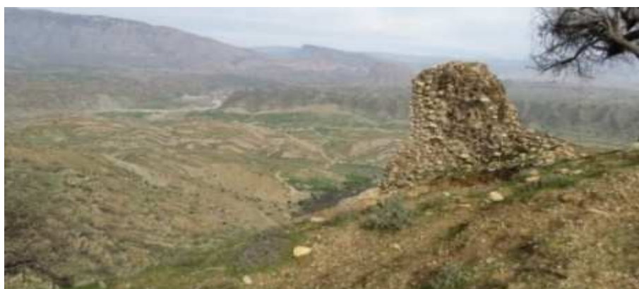
تصویر (۷) بقایای ساختمان ضلع شمال غربی دژ کوه
